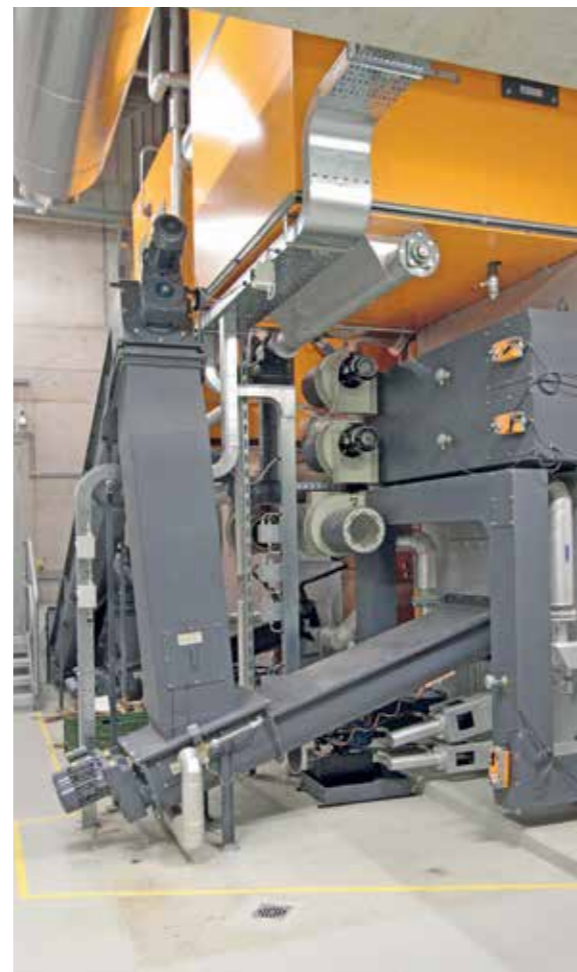
Vista del convogliamento cippato e delle condotte dell'aria di combustione
